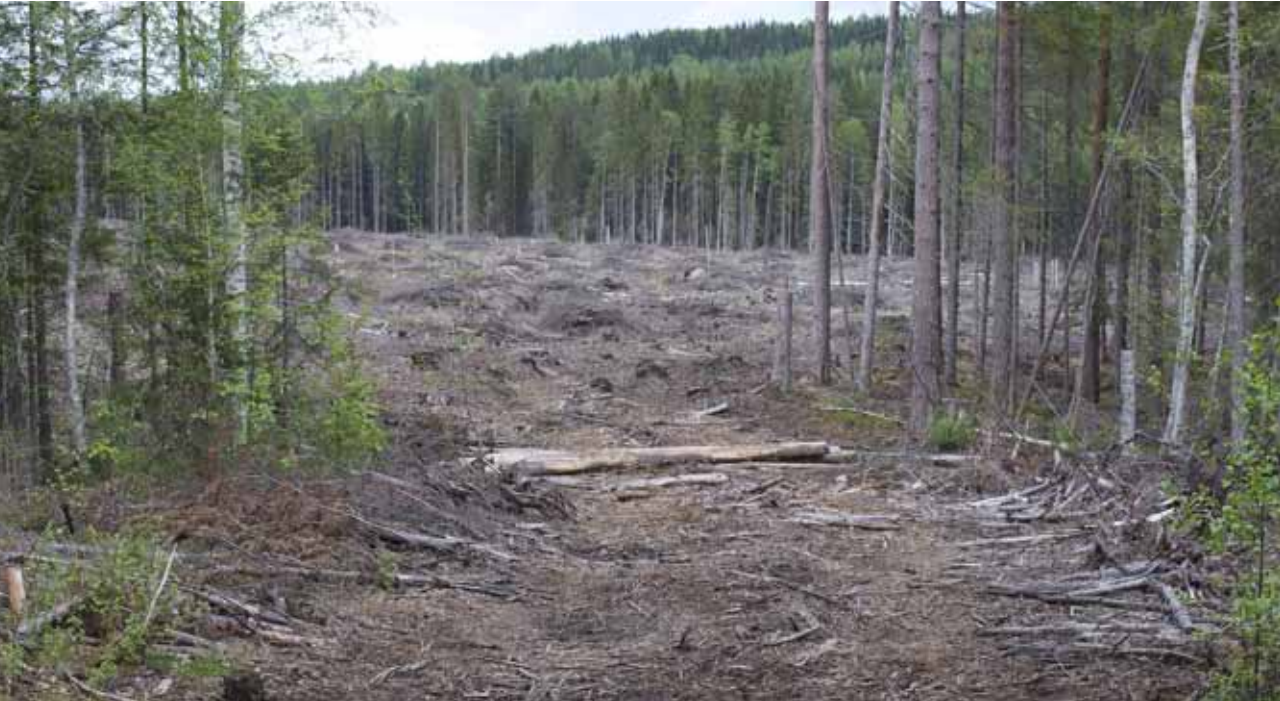
En tillfällig bro har byggts över ett vattendrag med hjälp av virke från beståndet. På- och avfart kavldes och risades noggrant. Foto Eva Ring
