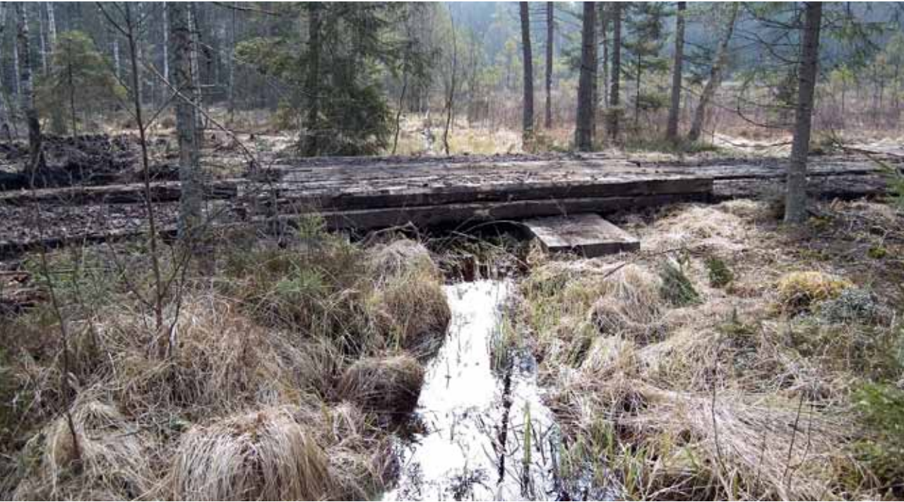
En tillfällig bro har byggts av stockmattor och på och avfarten har skyddats med ris. Foto Eva Ring
