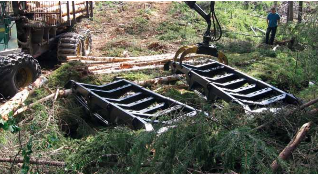
Överfart med hjälp av en portabel stålbro. På- och avfarten har risats och kavlats. Foto Per Simonsson
